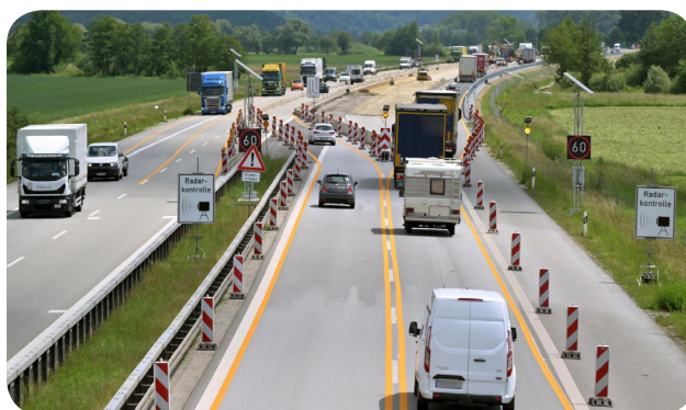
Baustelle Metten; Quelle: Hajo Dietz
